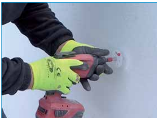
Amplasarea diblurilor pentru fixarea plăcilor de polistiren expandat (EPS)
