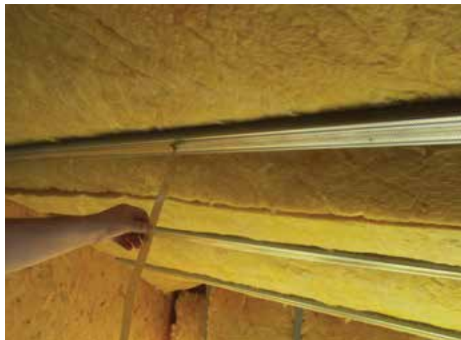
Figura 27. Înlăturarea stratului de protecție a benzii ISOVER Vario® DoubleTwin
