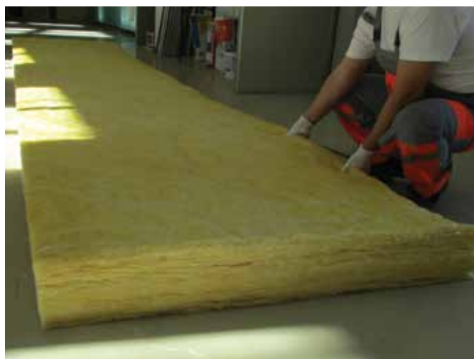
Figura 13. Revenirea saltelei de vată minerală la grosimea nominală
