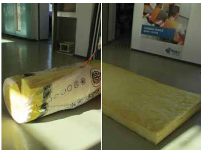
Figura 12. Dezambalarea unei role de vată minerală
