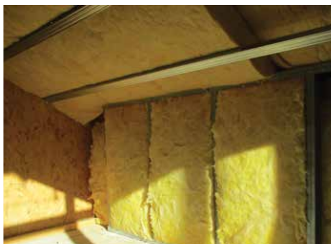
Figura 24. Stratul de vată minerală din fața popilor în zona de placare verticală
