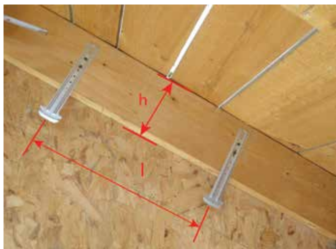
Figura 7. Distanța între ancore pe un căprior și înălțimea căpriorului
