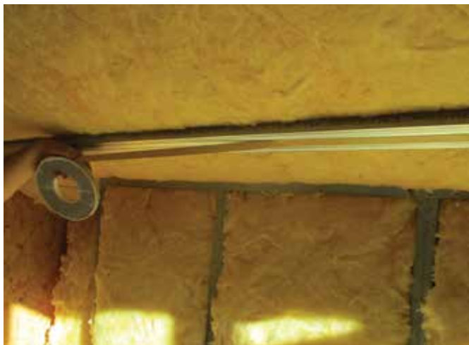
Figura 26. Lipirea benzii ISOVER Vario® DoubleTwin pe profilele CD 60/27
