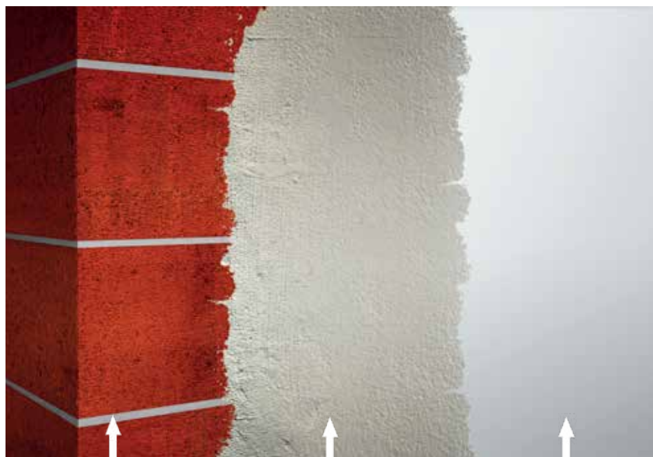
zidărie cărămidă/ BCA/beton*
