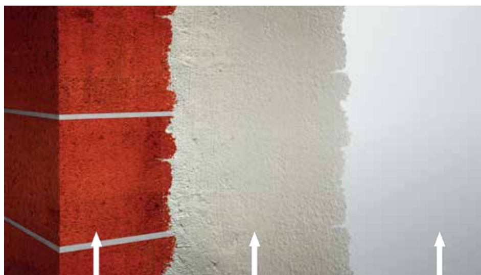
zidărie cărămidă/ BCA/beton*
