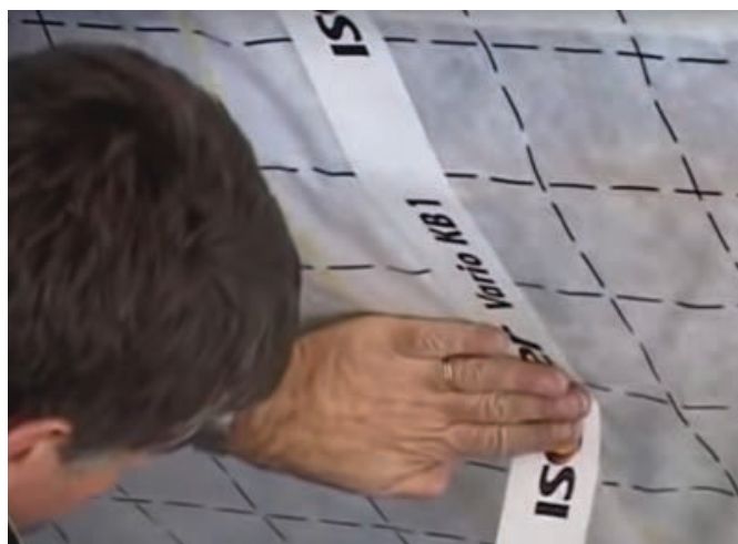
Figura 33. Aplicarea benzii ISOVER Vario® KB1 între două bucăți de membrană
