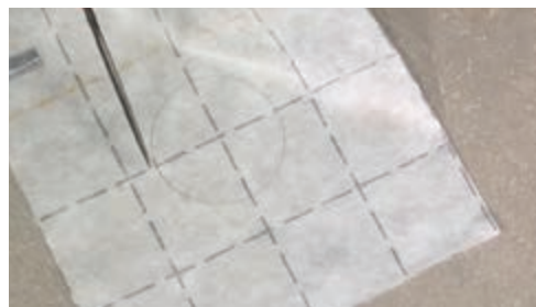
Figura 53. Decuparea bucății de membrană pentru finalizarea etanșării străpungerii
