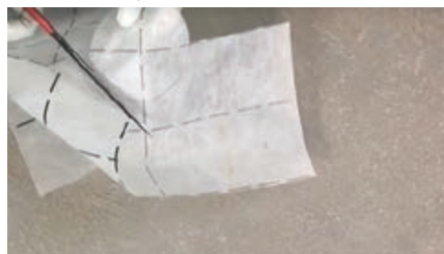
Figura 54. Decuparea bucății de membrană pentru finalizarea etanșării străpungerii
