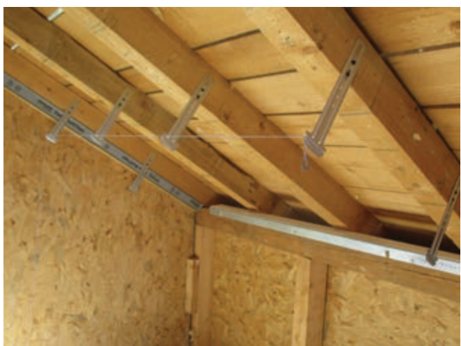
Figura 11. Ancore alinate pe un nivel
