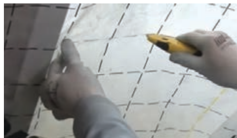
Figura 41. Decuparea membranei ISOVER Vario® KM Duplex UV în dreptul unei ferestre de mansardă
