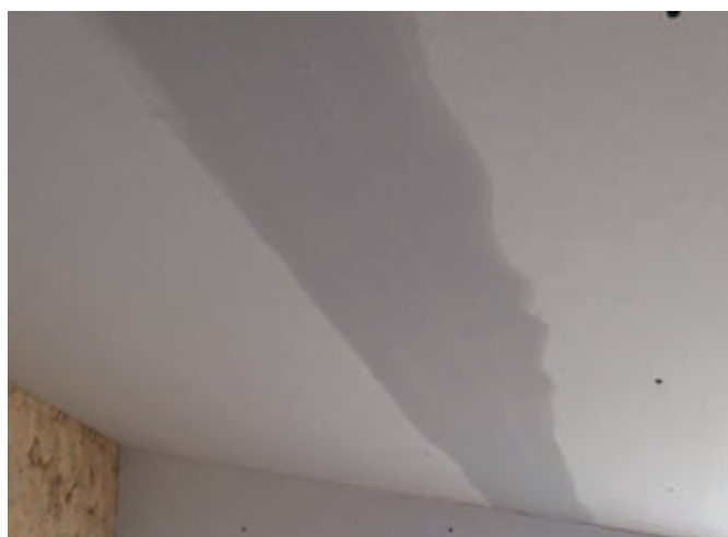
Figura 71. Aplicarea stratului de chit de rosturi peste banda de armare
