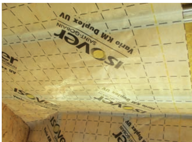
Figura 29. Montarea bucăților de ISOVER Vario® KM Duplex UV pe profilele CD 60/27
