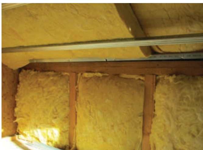
Figura 23. Stratul de vată minerală dintre popi în zona de placare verticală
