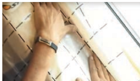
Figura 44. Introducerea membranei în șanțul ramei ferestrei
