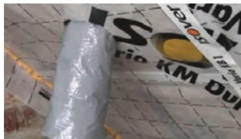
Figura 46. Decuparea membranei ISOVER Vario® KM Duplex UV în zona străpungerii cu o tubulatură
