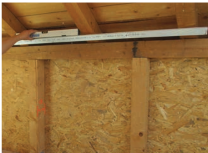
Figura 4. Poziționarea profilului Rigiprofil® UW la zona inferioară a plăcii înclinate
