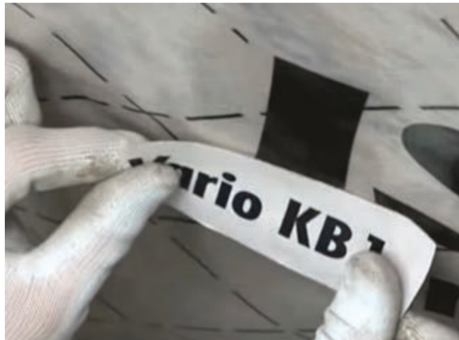
Figura 34. Aplicarea benzii ISOVER Vario® KB1 în zonele în care membrana a fost ruptă accidental
