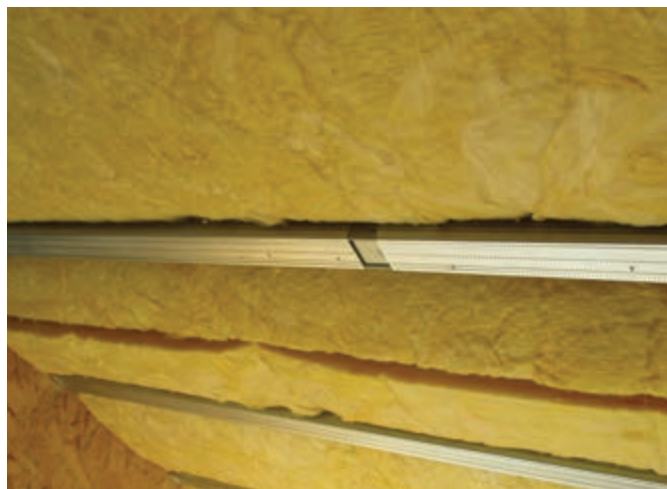
Figura 22. Montarea piesei de prelungire între două profile CD 60/27
