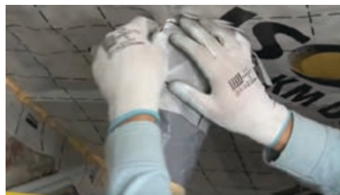
Figura 49. Aplicarea bucății de membrană pentru etanșarea străpungerii cu o tubulatură
