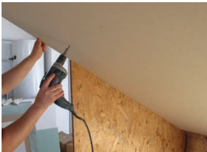
Figura 57. Montarea plăcilor din gips-carton
