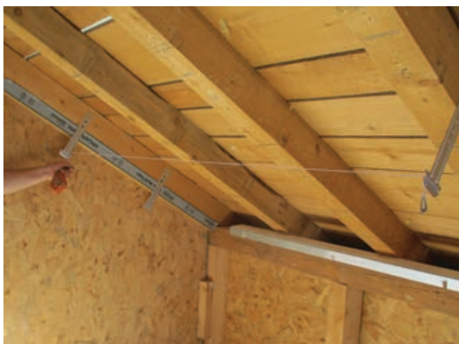
Figura 9. Întinderea de sfori între ancorele aflate la același nivel
