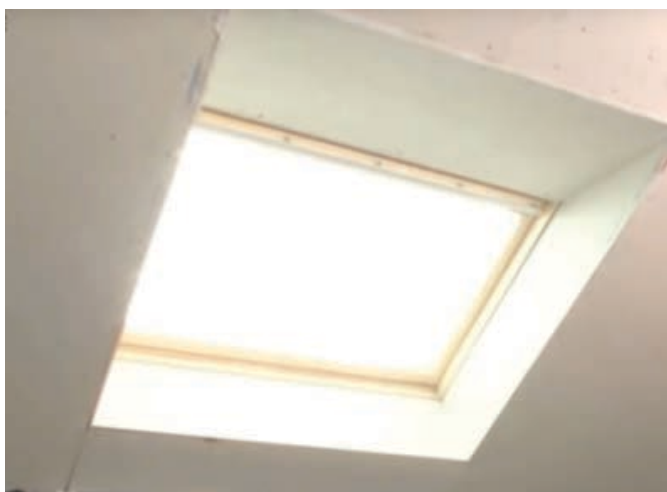
Figura 63. Montarea plăcilor din gips-carton la joncțiunea cu un calcan și în deschiderea unei ferestrei de mansardă
