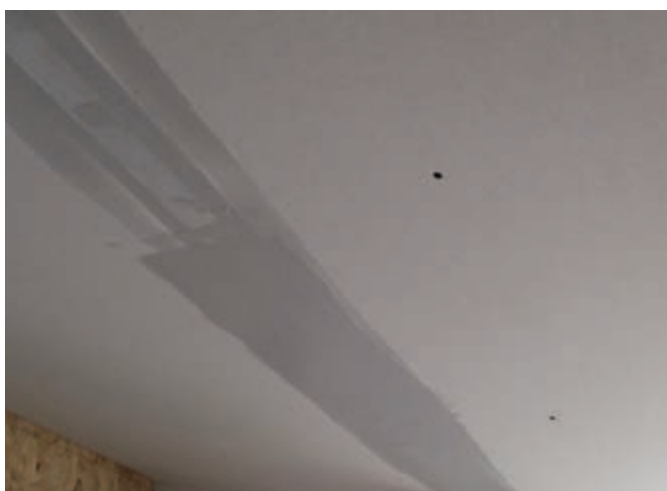
Figura 70. Aplicarea stratului de chit de rosturi peste banda de armare
