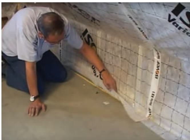
Figura 37. Etanșarea zonei de joncțiune dintre placarea verticală și planșeu cu masticul ISOVER Vario® DoubleFit
