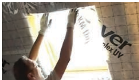
Figura 42. Aplicarea membranei ISOVER Vario® KM Duplex UV în dreptul unei ferestre de mansardă
