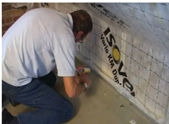
Figura 35. Etanșarea zonei de joncțiune dintre placarea verticală și planșeu cu masticul ISOVER Vario® DoubleFit
