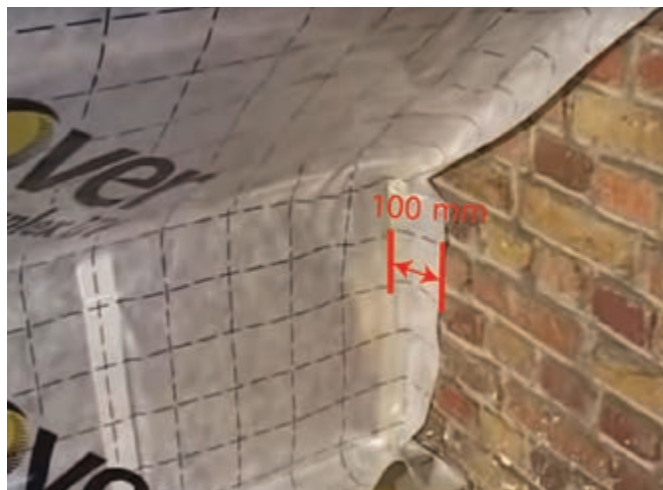
Figura 32. Zona de joncțiune dintre placarea verticală și planșeu
