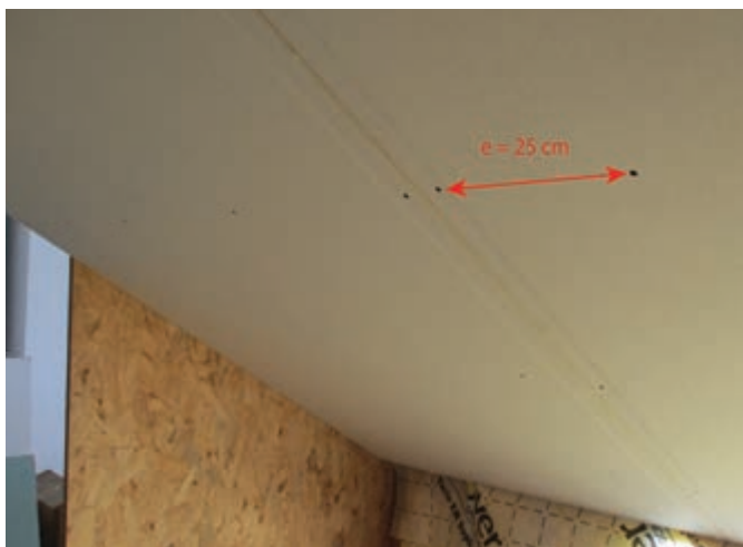
Figura 59. Montarea plăcilor din gips-carton cu șuruburi autofiletante Rigips® 212
