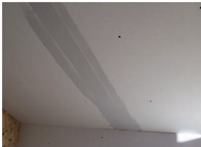
Figura 67. Aplicarea chitului de rosturi la îmbinarea dintre plăcile din gips-carton
