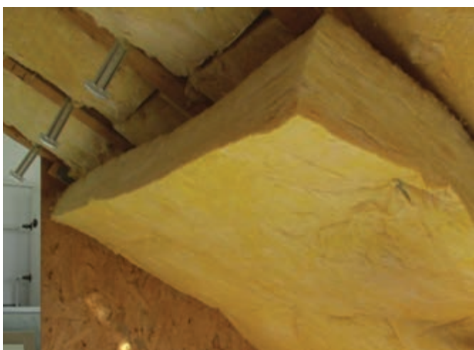
Figura 20. Trecerea ancorelor prin stratul de vată minerală de sub căpriori
