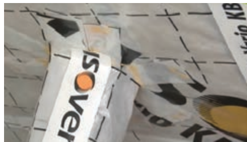
Figura 52. Manșonul de membrană lipit pe tubulatura care străpunge produsul termoizolant
