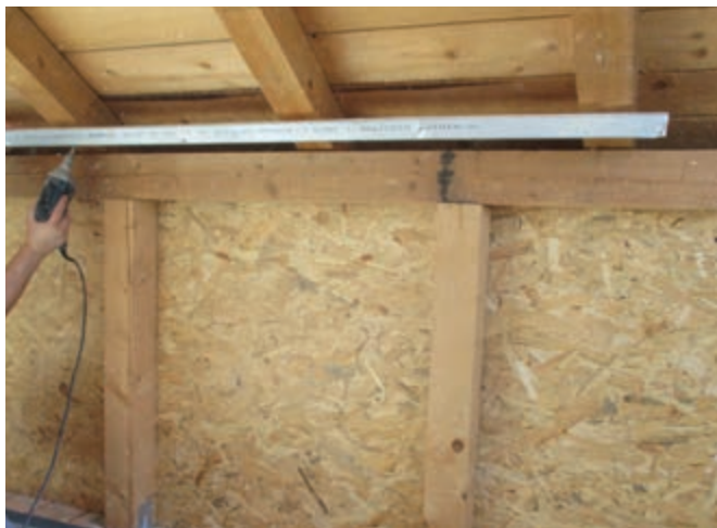
Figura 5. Montarea profilului Rigiprofil® UW la zona inferioară a plăcii înclinată
