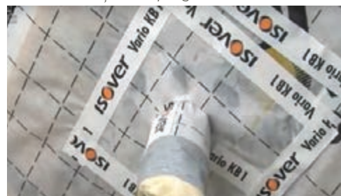
Figura 56. Lipirea bucății de membrană pentru finalizarea etanșării străpungerii
