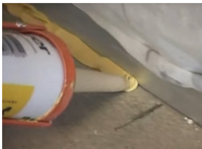
Figura 36. Etanșarea zonei de joncțiune dintre placarea verticală și planșeu cu masticul ISOVER Vario® DoubleFit
