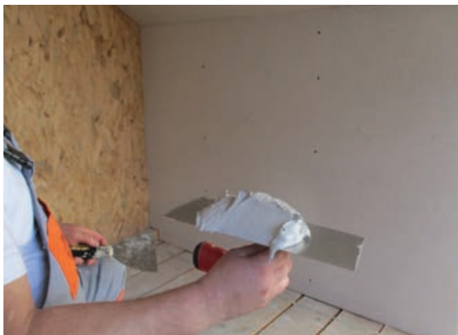
Figura 66. Aplicarea chitului de rosturi la îmbinările dintre plăcile din gips-carton
