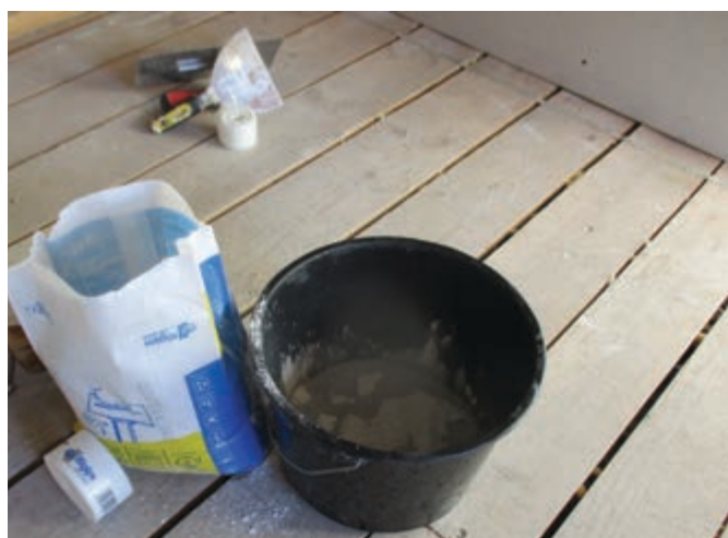
Figura 65. Produse și unelte folosite pentru chituirea rosturilor
