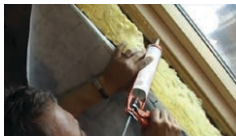
Figura 43. Etanșarea perimetrului unei ferestre de mansardă cu mastic ISOVER Vario® DoubleFit
