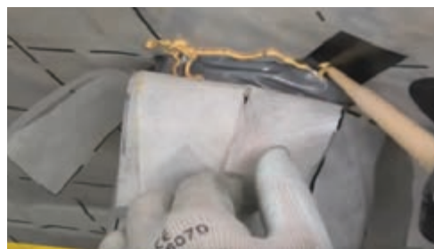
Figura 51. Aplicarea perimetrală a masticului ISOVER Vario® DoubleFit pentru etanșarea străpungerii
