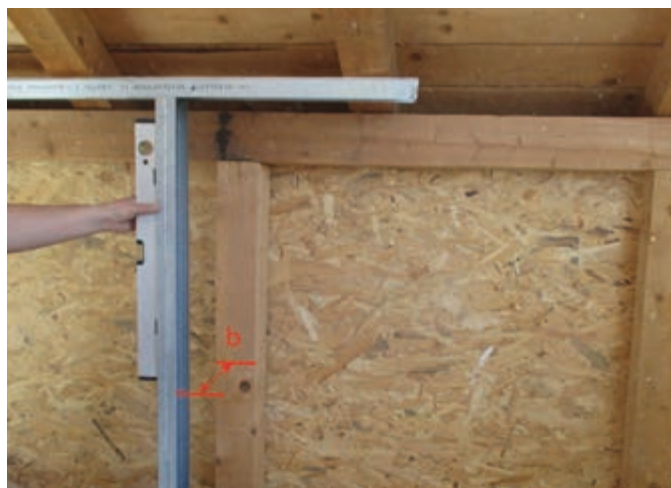
Figura 6. Montarea profilului Rigiprofil® UW pe planșeu.
