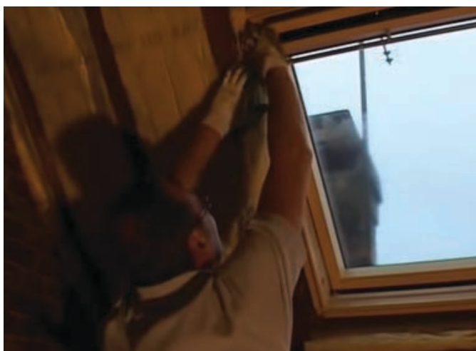
Figura 18. Umplerea cu vată minerală a cavităților rămase neizolate
