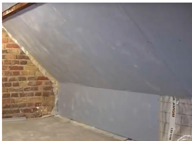
Figura 64. Etanșarea la joncțiunea membranei ISOVER Vario® KM Duplex UV cu un calcan
