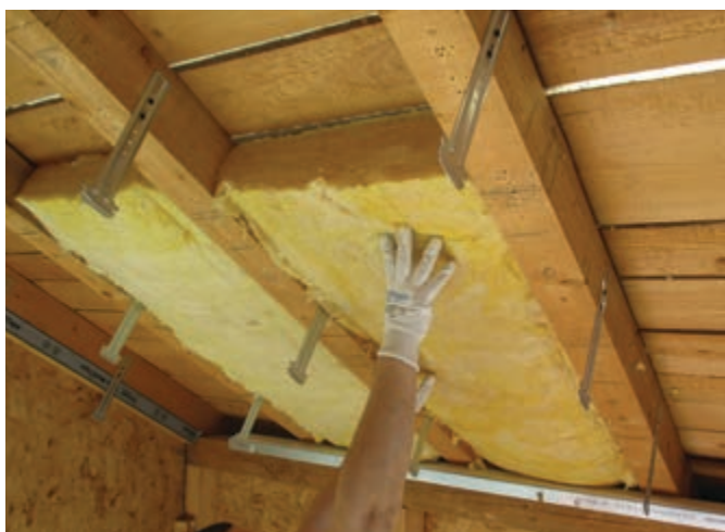
Figura 16. Montarea unei bucăți de vată minerală între căpriorii unei zone de acoperiș
