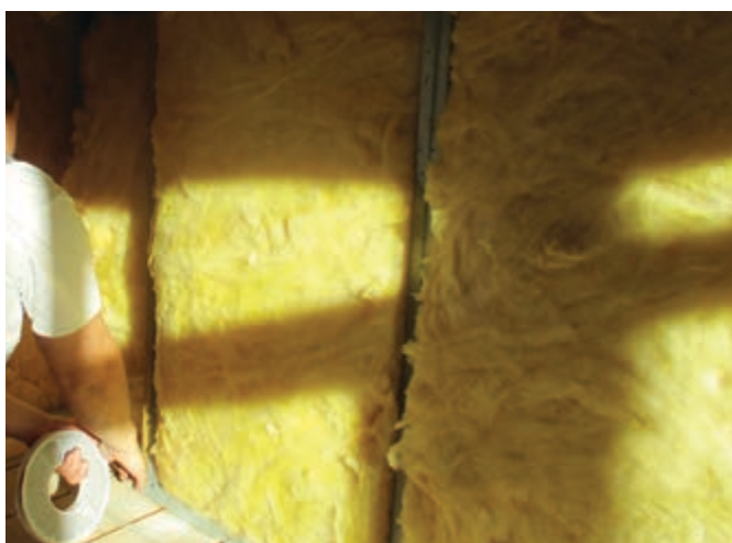
Figura 28. Lipirea benzii ISOVER Vario® DoubleTwin pe profilele CW și UW din zona de placare verticală
