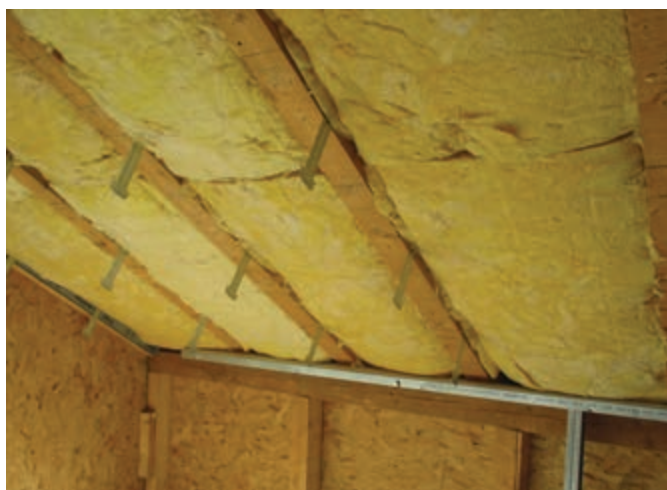
Figura 17. Vata minerală ISOVER FORTE între căpriorii unei zone de acoperiș
