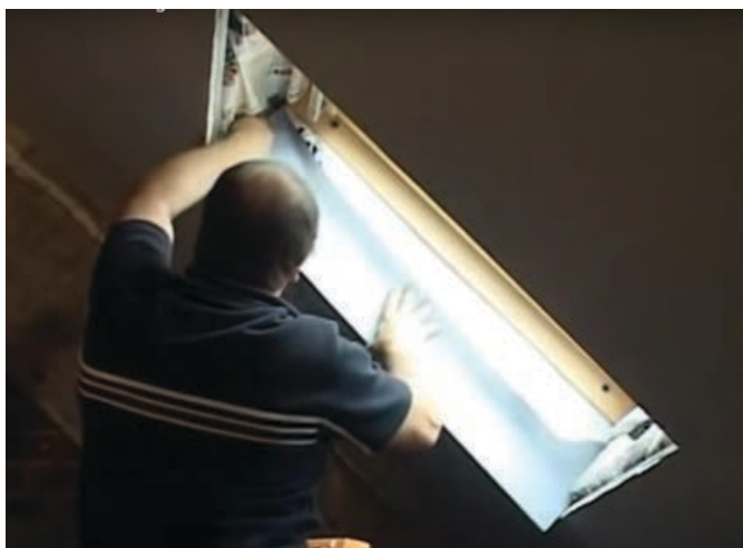
Figura 61. Montarea plăcilor din gips-carton la joncțiunea cu rama ferestrei de mansardă
