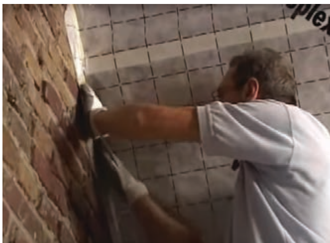
Figura 39. Etanșarea zonei de joncțiune dintre placarea înclinată și calcan cu masticul ISOVER Vario® DoubleFit
