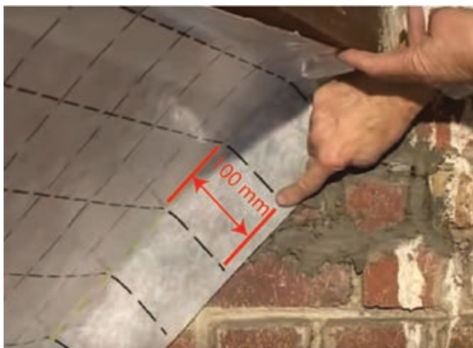
Figura 31. Zona de joncțiune dintre șarpantă și calcan
