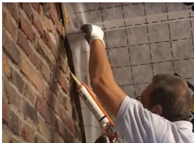
Figura 38. Etanșarea zonei de joncțiune dintre placarea înclinată și calcan cu masticul ISOVER Vario® DoubleFit
