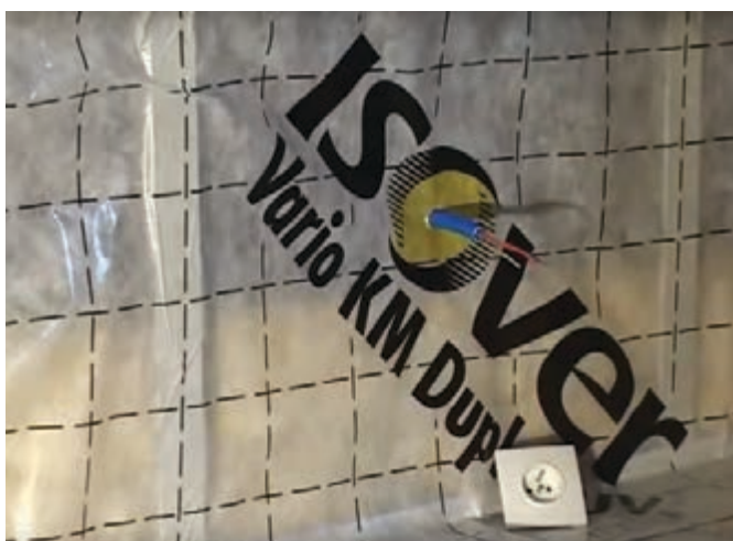
Figura 40. Străpungerea membranei ISOVER Vario® KM Duplex UV cu cabluri electrice
