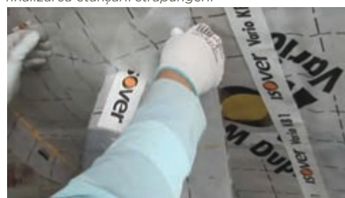
Figura 55. Aplicarea bucății de membrană pentru finalizarea etanșării străpungerii
