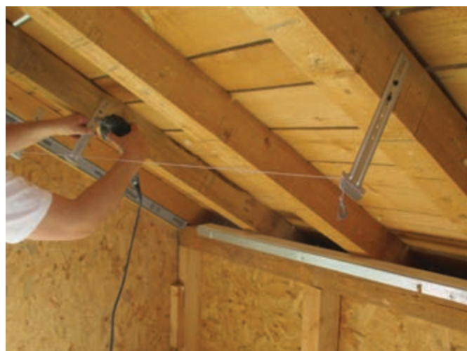
Figura 10. Alinierea unei ancore față de ancorele aflate la același nivel cu ajutorul sforii
