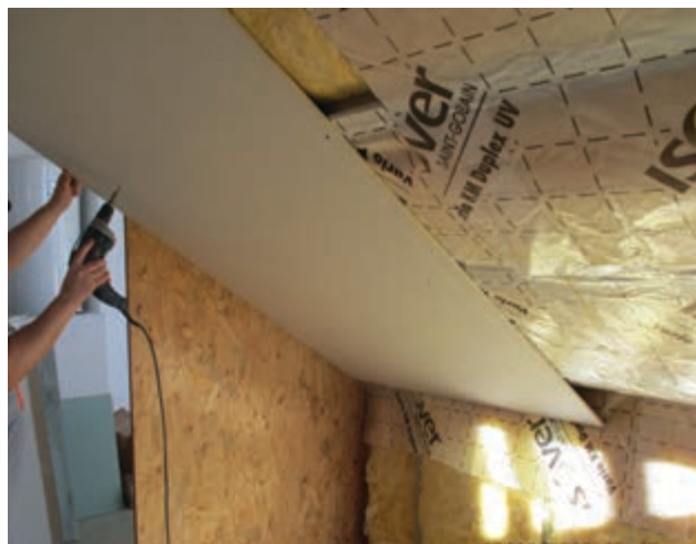
Figura 58. Montarea plăcilor din gips-carton cu șuruburi autofiletante Rigips® 212
