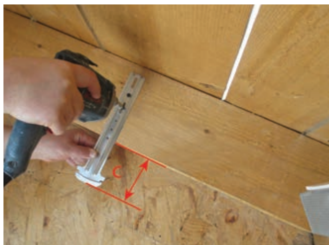
Figura 8. Montarea ancorelor pe căprior
