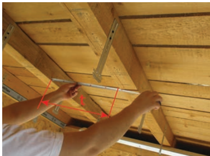
Figura 14. Măsurarea distanței t dintre fețele căpriorilor unei zone de acoperiș
