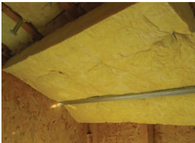
Figura 21. Montarea profilului CD 60/27 în ancore
