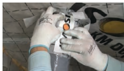
Figura 50. Lipirea longitudinală a bucății de membrană pentru etanșarea străpungerii cu o tubulatură
