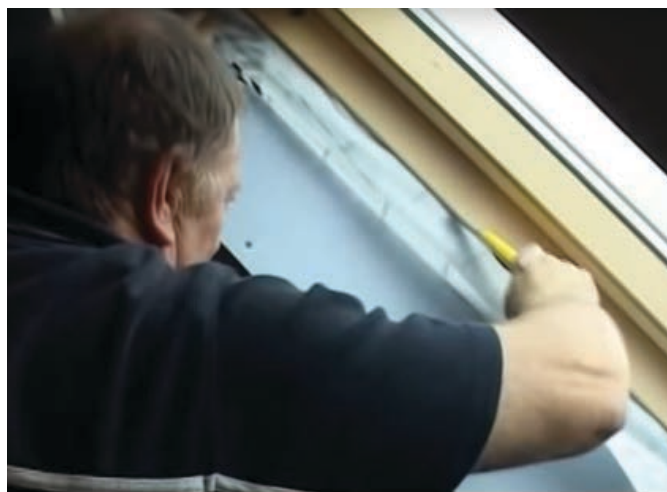
Figura 62. Decuparea membranei ISOVER Vario® KM Duplex UV la joncțiunea cu rama ferestrei de mansardă
