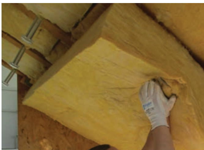
Figura 19. Montarea stratului de vată minerală sub căpriori
